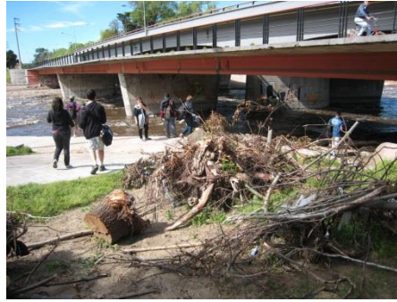
写真 12 洪水の被害調査
