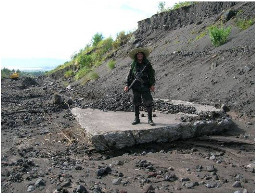
写真 IV-4 土石流により破壊された砂防ダムの破片。スケールとなってくれた方は、警護のために付き添ってくれた武装警官。
